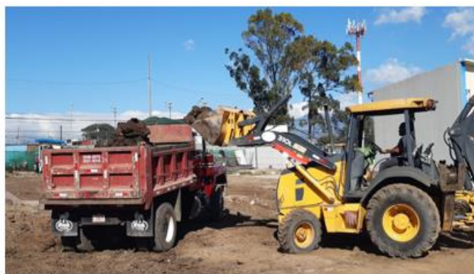
Inicio de obras Almendares II
