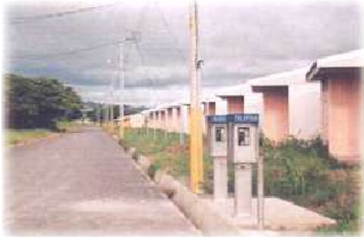
Con la construcción de los proyectos habitacionales también se ha dotado a las comunidades de infraestructura y servicios de gran utilidad.
