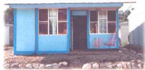
En un esfuerzo solidario se incrementó el monto del bono de vivienda, de esta manera las casas construidas a partir de este año pasarán de 42 a 50 metros cuadrados
