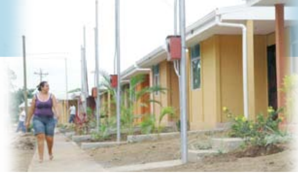
Proyecto Palmira III, Carrillo, Guanacaste.
