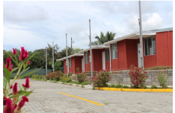
El 2013 marcó la consolidación del proceso de supervisión de la calidad constructiva en todos los proyectos financiados con el bono, como en el caso de San Martín ubicado en Pococí, Limón.
