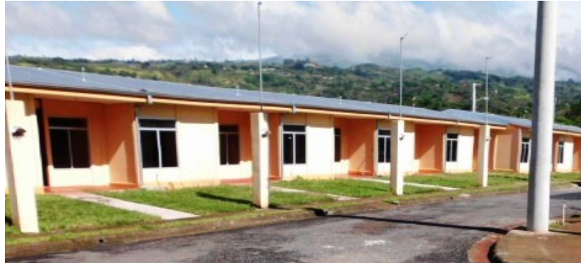
El Proyecto Ajenjal, que es el primero aprobado en la administración Solís Rivera, posee calles asfaltadas, aceras de concreto, cordón y caño, acueducto y red de distribución de energía eléctrica con sus luminarias.
