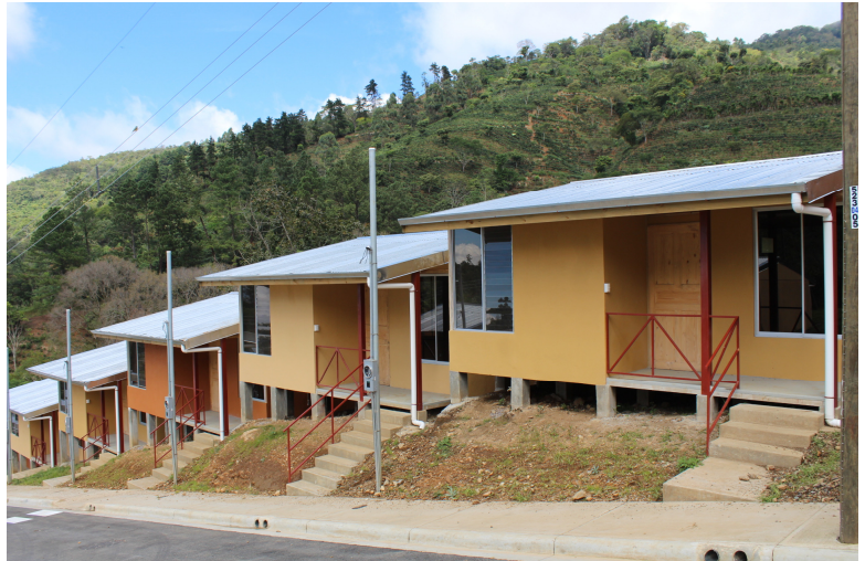
21 familias de Palmichal de Acosta, afectadas por el huracán Mitch y la tormenta Thomas; ahora cuentan con vivienda propia en el Residencial Vida Nueva, en el cual se empleó un sistema constructivo que combina vigas y columnas de madera con paneles modulares de micro-concreto reforzado.
