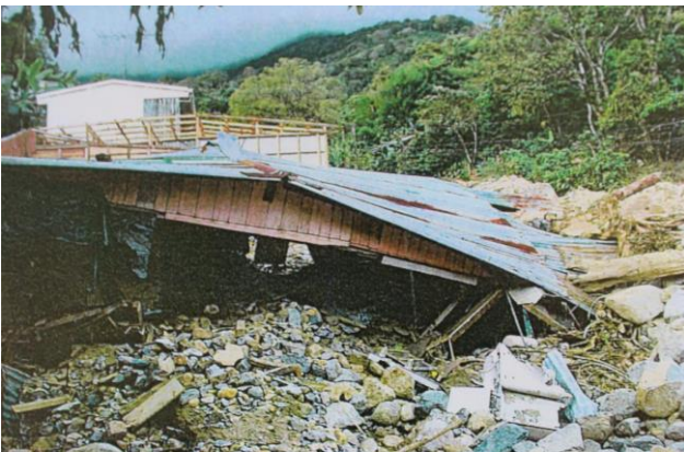
Así quedó la casa de Marcial Solano en Barrio Lourdes luego de la cabeza de agua.
