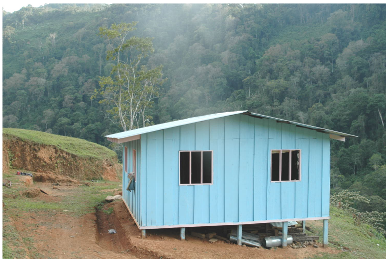
Vivienda construida en Territorio Indígena Chirripó Cábecar, Turrialba
