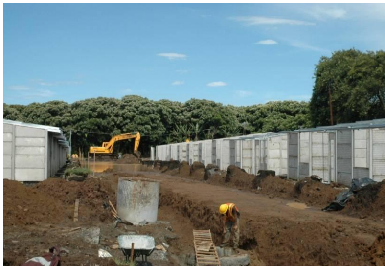
Proyecto La Zamora, Heredia. En construcción.
